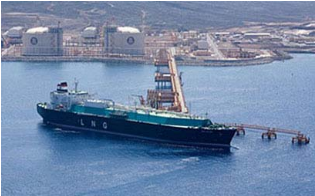
Balhaf LNG Terminal
