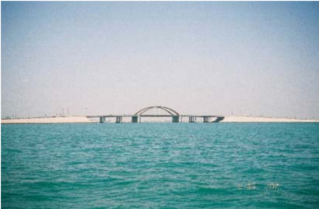
Mina Salman—Khawr al Qulayah Bridge
