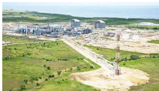
Caution Bay LNG Plant
