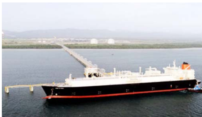
Caution Bay LNG Terminal
