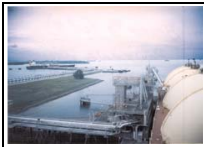
Bontang LNG Terminal—Berth No. 3
