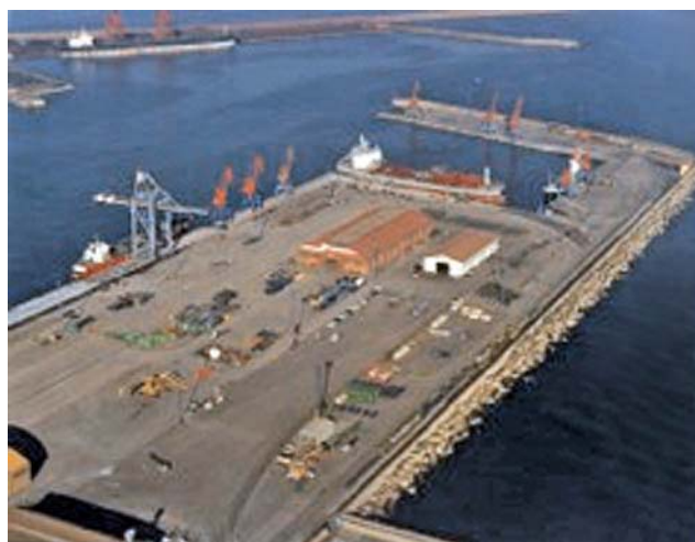
Gijón—Muelle de la Osa
