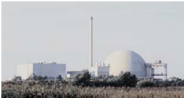
Unterweser (Esenshamm) Nuclear Power Plant
