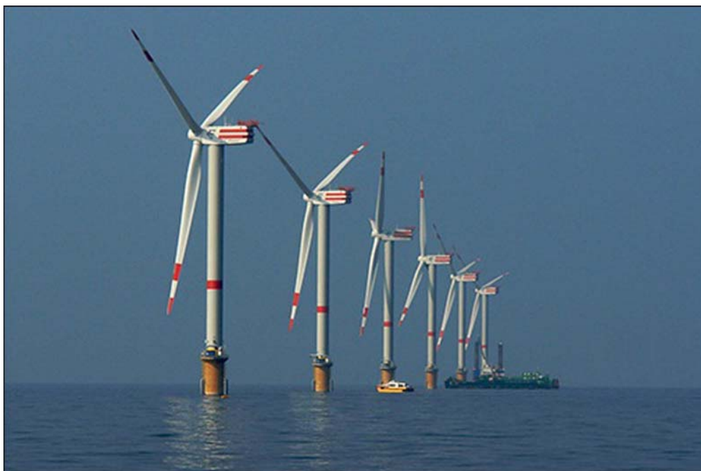
Thorntonbank Wind Turbines
