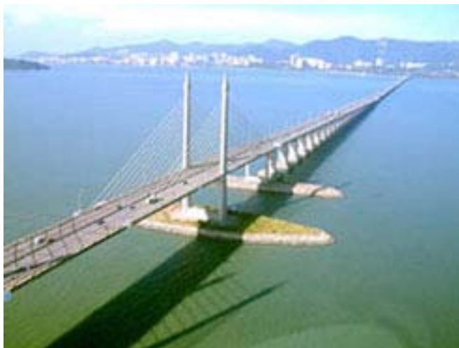
Jambatan Pulau Pinang
